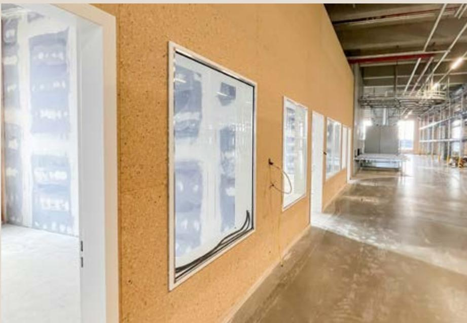
*Dans les trois étages de l'immeuble fonctionnel, des boîtes de bureau ont été réalisées avec des panneaux ELKA ESB. En raison de la qualité de surface élevée, la plaque a pu s'adapter comme une interface visuelle dans le bâtiment industriel.*
