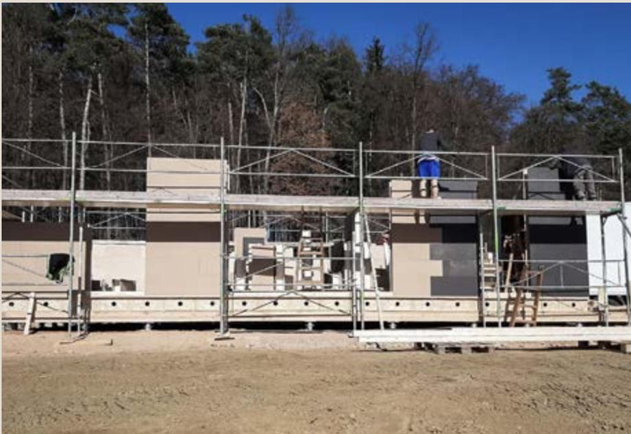
*Aucune grue ni équipement lourd n'est requis pour construire la maison. Cela permet également d'implanter des maisons dans des endroits impraticables avec le système Homebrick.*
