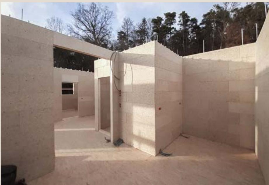
*La mise en place des murs est très rapide grâce au système de plug-in. Hannah Rabi a ensuite laissé la surface des panneaux esb visible à l'intérieur.*
