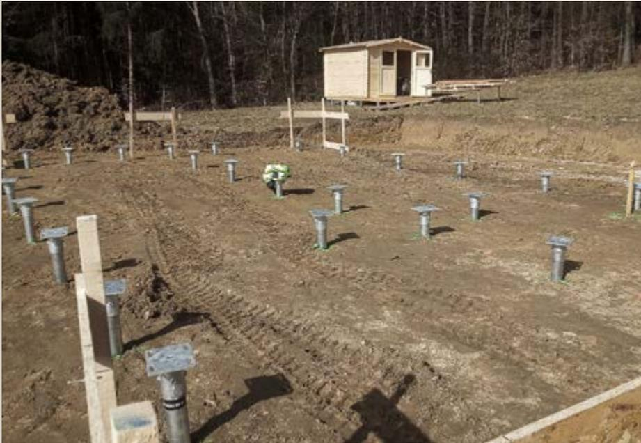
*La sous-structure composée de poutres en bois a été posée sur des fondations vissées. Cela signifiait qu'il n'était pas nécessaire de sceller le sol avec une plaque de sol classique*
