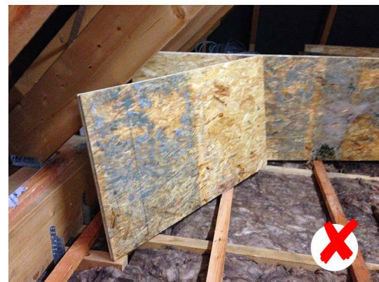
Keine gute Lösung im Dachspeicherboden sind z. B. diffusionsdichte Plattenwerkstoffe mit der Folge von Schimmel.
